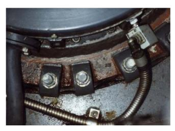
Am Stufenschalter eines Großtransformators drang Transformatorenöl durch mehrere Risse zwischen Deckel und Lastumschaltergefäß. Die Instandsetzung erfolgte nach dem direct-MM-bonding Verfahren mit MM-metall oL-StahlKeramik und Härter rot und nachfolgend Härter gelb.
